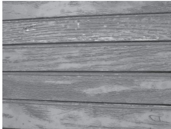
Φωτογραφία 162: Αποσάθρωση του ξύλου (weathering of wood) εξαιτίας της μακροχρόνιας έκθεσής του σε εξωτερικό περιβάλλον. Φωτογραφία του συγγραφέα.
